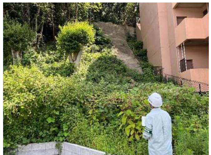
がけ点検状況（松戸市）
