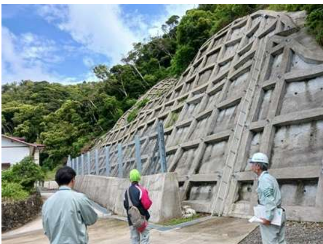
がけ点検状況（鴨川市）
